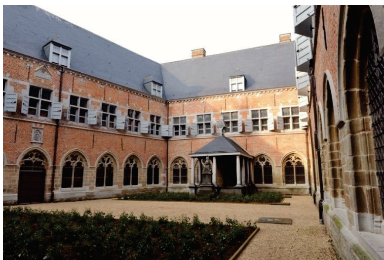
Cour intérieure de l'Hôtel-Dieu de Lessines
